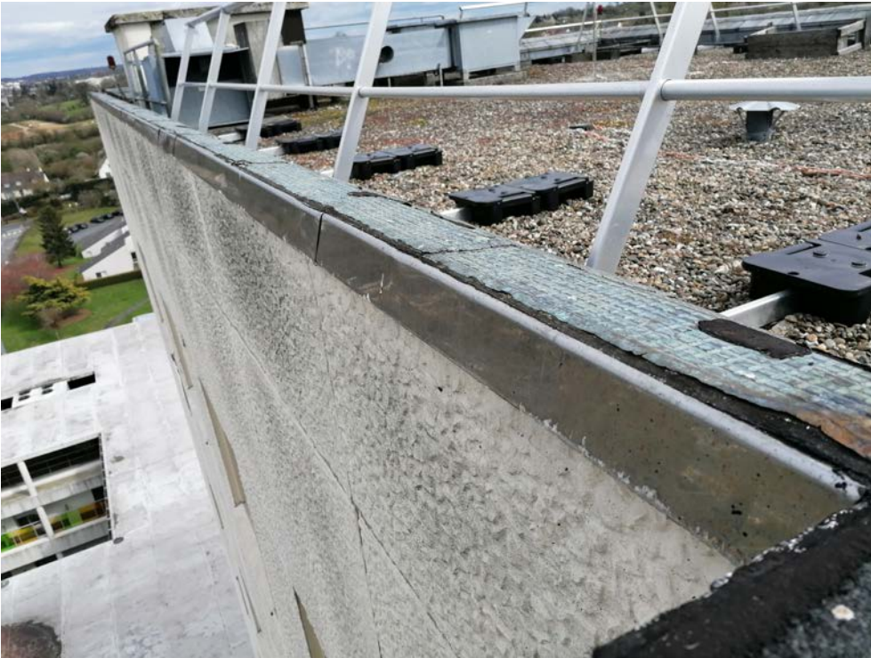
05-06. Altération de l'étanchéité des acrotères.
