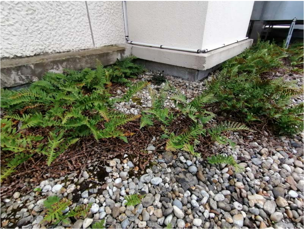
07. Développement de végétation sur la toiture.
