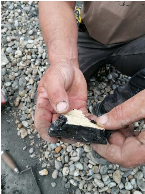
01. Sondage du complexe d'étanchéité.
