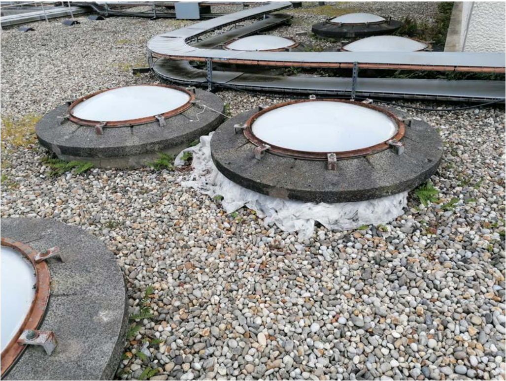
08. Altération des skydome.
