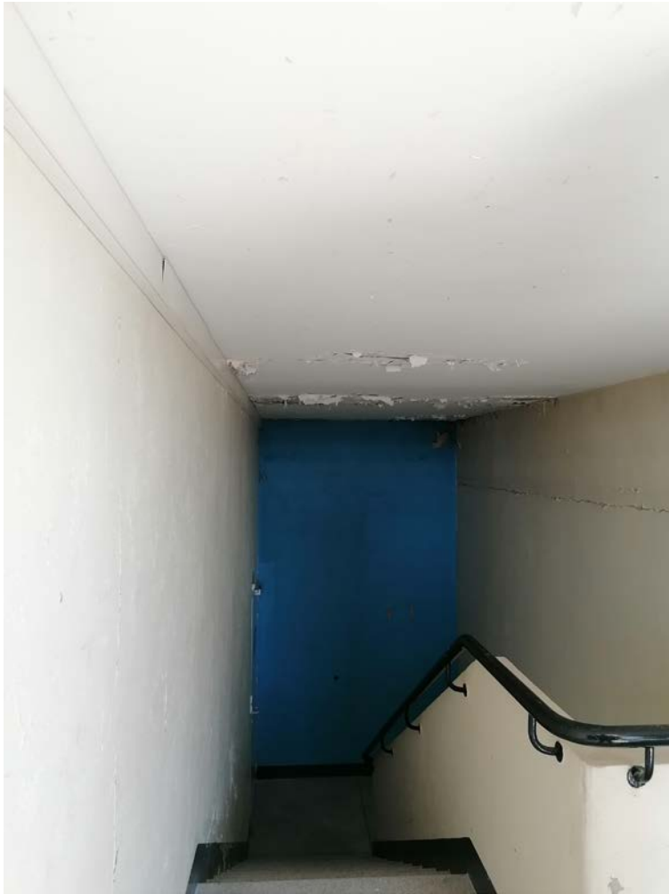
09-11. Traces d'infiltrations d'eau depuis les toitures.
